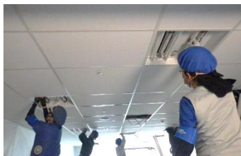
LED照明器具交換作業の様子
